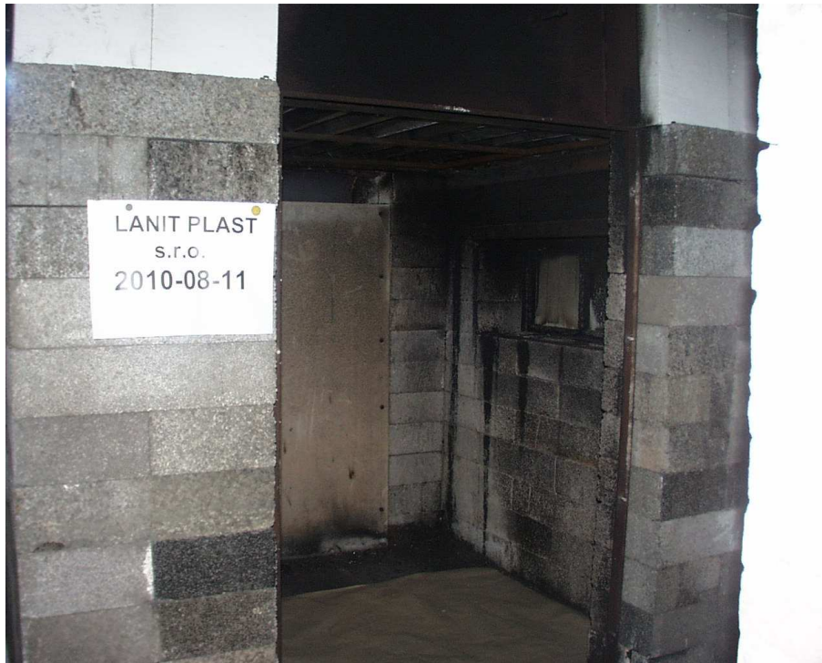
Pohled na zkušební vzorek č. 1 před zkouškou
